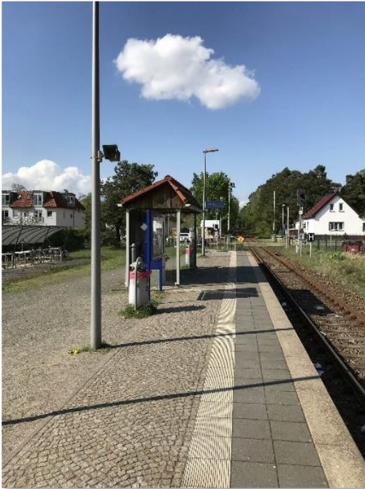
Abb. 29: Regionalbahnhaltestelle 'Bhf. Bad Saarow': Hoher Ausbaugrad
