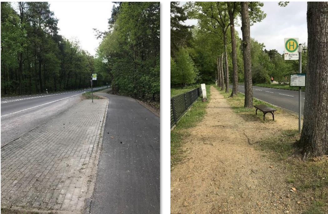
Abb. 30: Ausbaubedarf von Bushaltestellen: Beispiel Bushaltestellen 'Fürstenwalder Str.' und 'Hafen' in südlicher Fahrtrichtung
